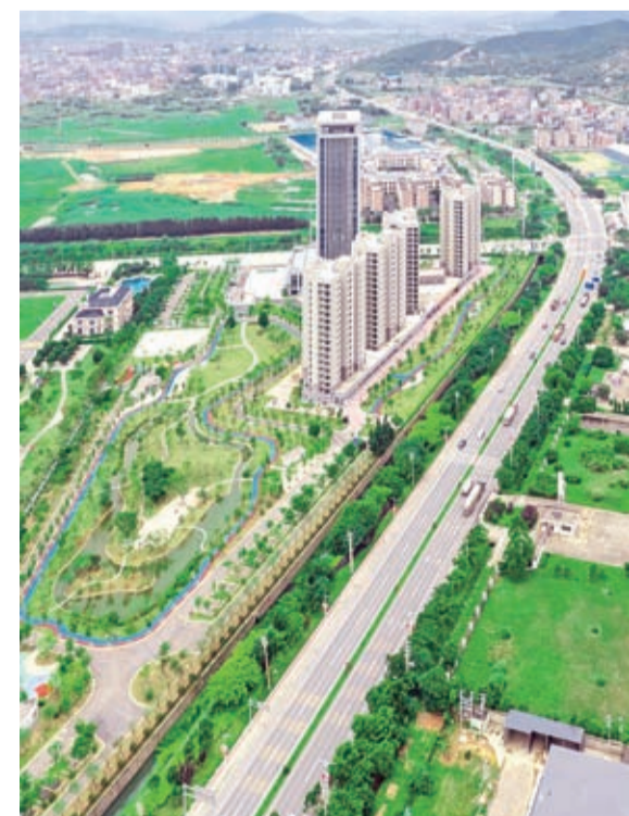
作為園區重要基礎項目，海城路沿綫提升改造工程效果顯著。(林雙偉 攝)
